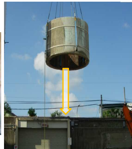
切断煙突吊り下ろし
