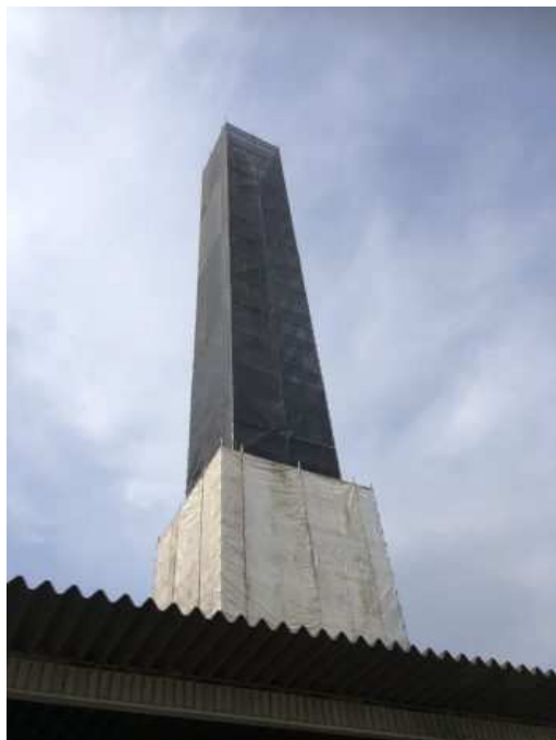
煙突養生状況
