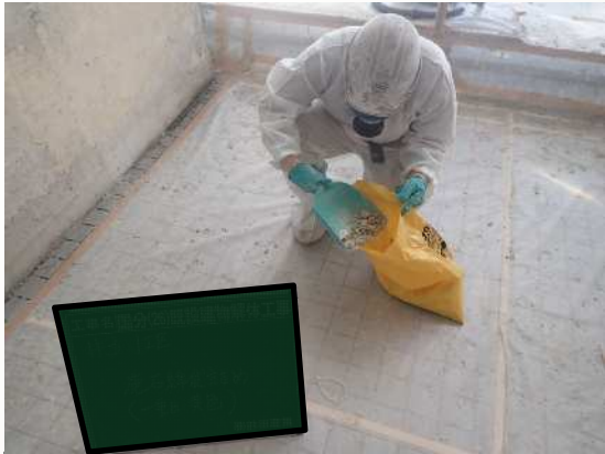
アスベスト除去・梱包状況 一重目
