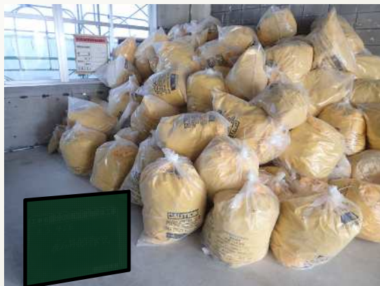
アスベスト保管状況 二重目
