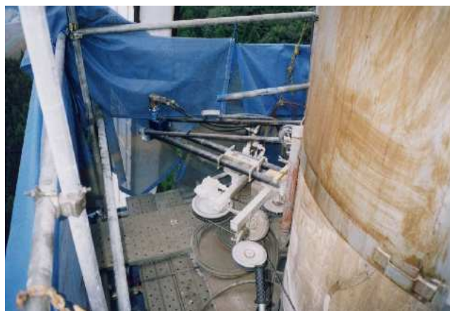
煙突切断状況
