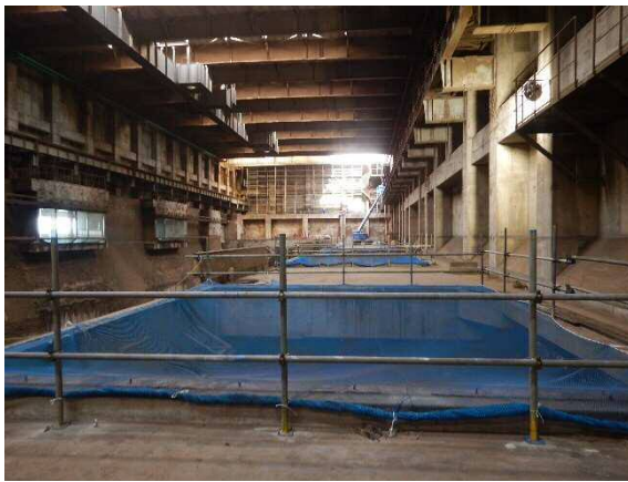
写真② ごみ投入ホッパーステージ解体状況
