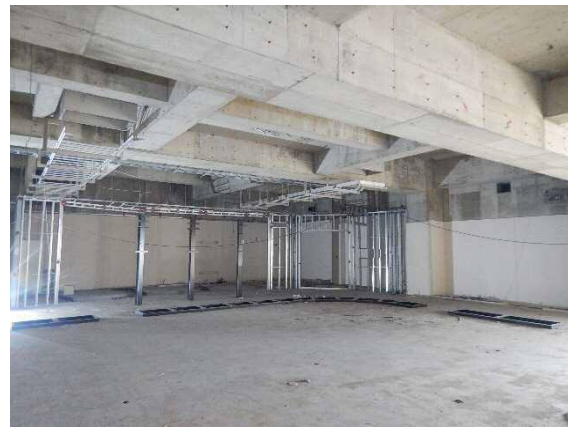
写真⑤ 2F 中央管制室解体状況
