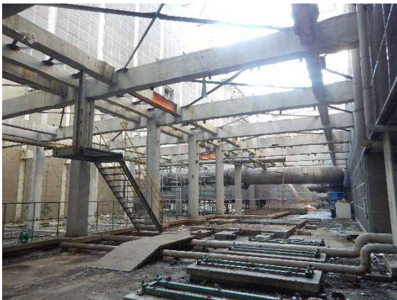
写真④ 吸気エリア解体状況
