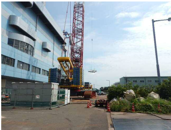
写真② 解体荷下し状況1
