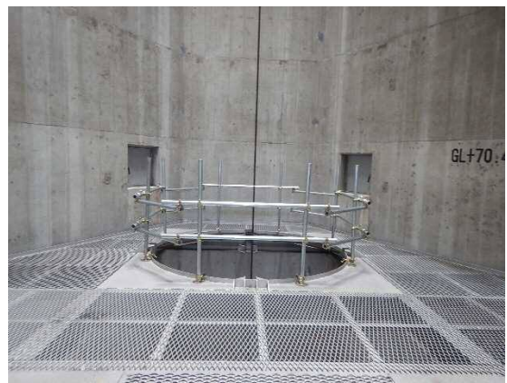
写真⑤ 煙突内筒撤去完了状況
