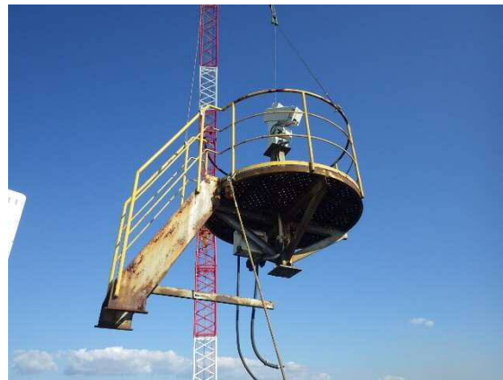
写真③ 解体荷下し状況2
