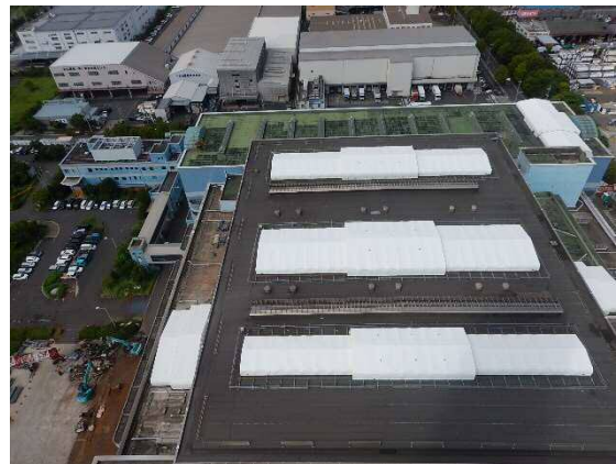
写真① 屋根部仮設テント設置状況
