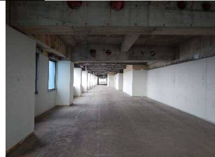
写真② 5階見学者通路内装撤去完了状況
