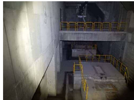
写真⑤ 誘引通風機解体完了状況
