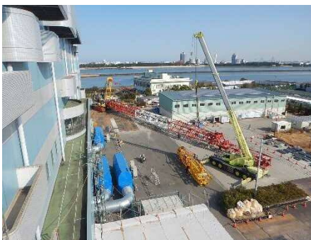
写真④ クレーン組立て状況
