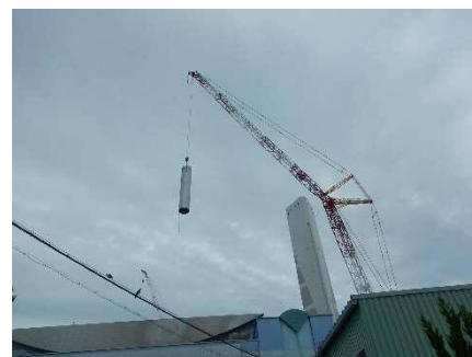
写真⑤ 煙突内筒解体状況
