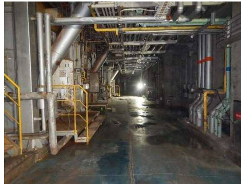
写真② 焼却炉室内2次洗浄完了状況。
