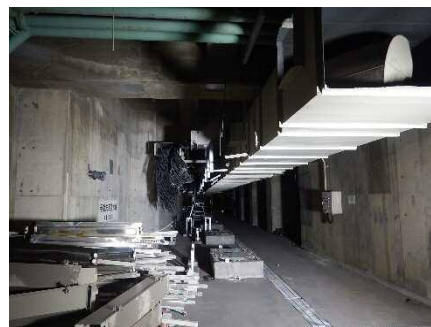
写真③ 地下2階設備解体状況
