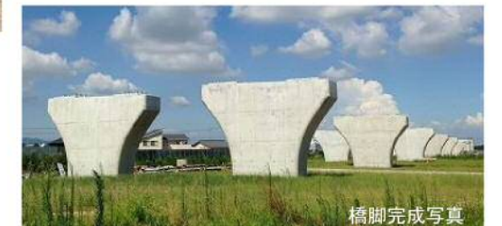
橋脚完成写真
