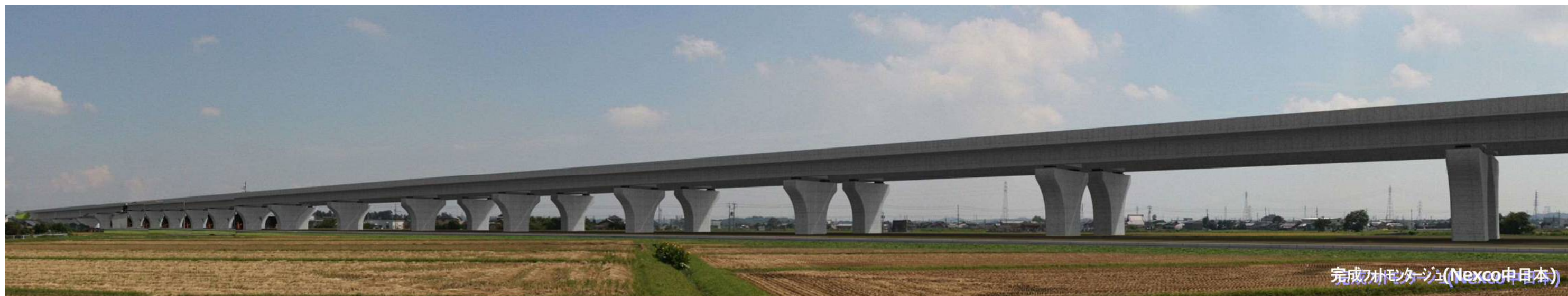
終点側鋼箱桁橋(鋼上部工工事)
